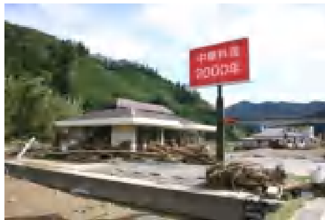
災害写真 H16.10 はんの 郡上市美並町母野(郡上市・美濃市境) 国道156号から撮影
