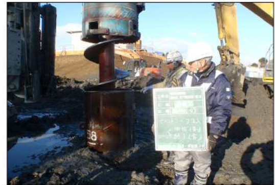
セメントミルク注入
