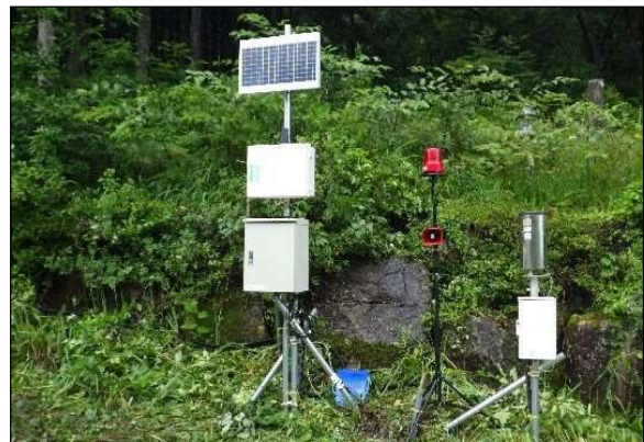
雨量計設置状況（西洞・高山市朝日町地内）
