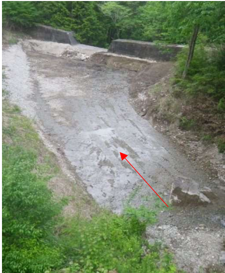
砂防堰堤の土砂堆積状況（坂本谷 下呂市馬瀬地内）
