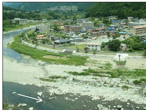
令和元年6月完成
