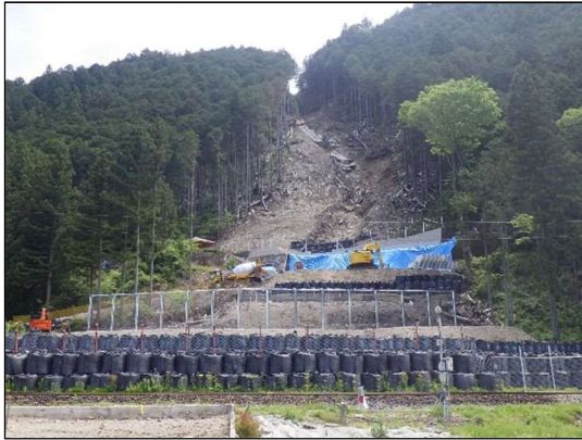
平成30年7月豪雨災害後の応急対策事例（金子谷・下呂市萩原町地内）
