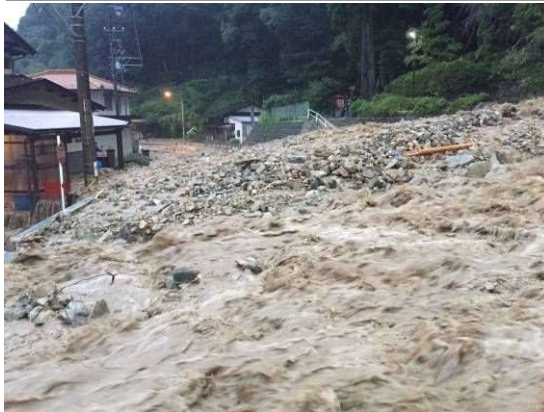
下呂市小坂町長瀬白土洞地内 土砂流出状況
