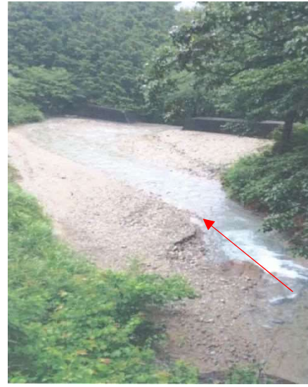
砂防堰堤の土砂堆積状況（坂本谷 下呂市馬瀬地内）
