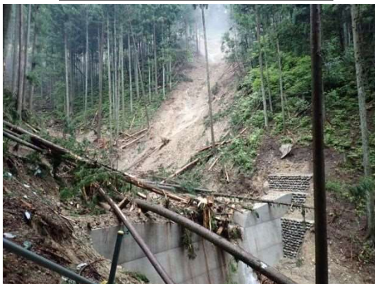
治山ダムによる土砂、流木の捕捉 (下呂市萩原町上呂門洞地内)
