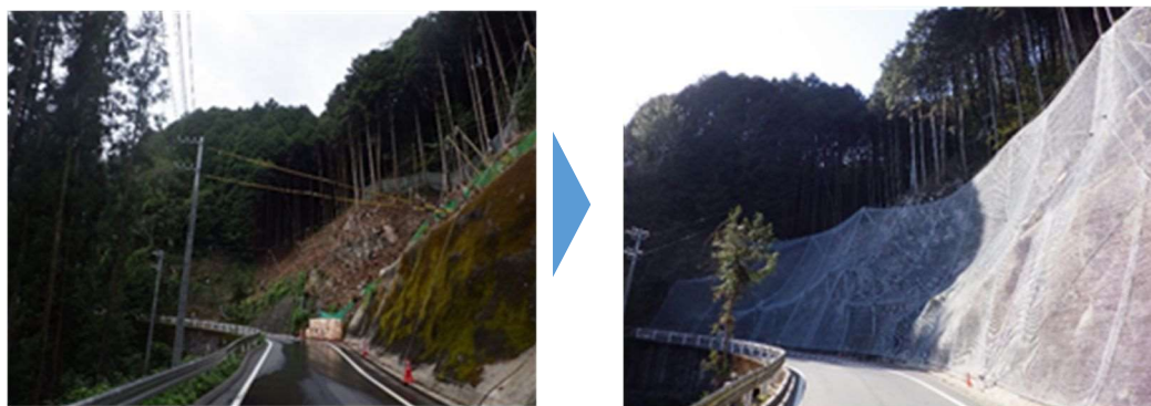
一般県道恵那八百津線 恵那市笠置町河合地内の落石対策例
