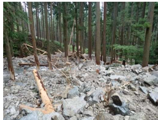
立木による土砂の捕捉 (下呂市萩原町上呂樋洞地内)
