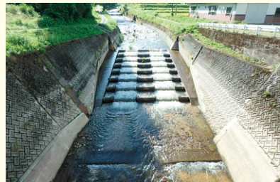
土砂で埋まってしまった魚道を修繕（土砂撤去）することで、魚道としての機能を回復します。
