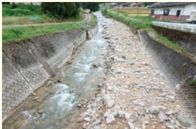
土砂で埋まってしまった魚道を修繕（土砂撤去）することで、魚道としての機能を回復します。
