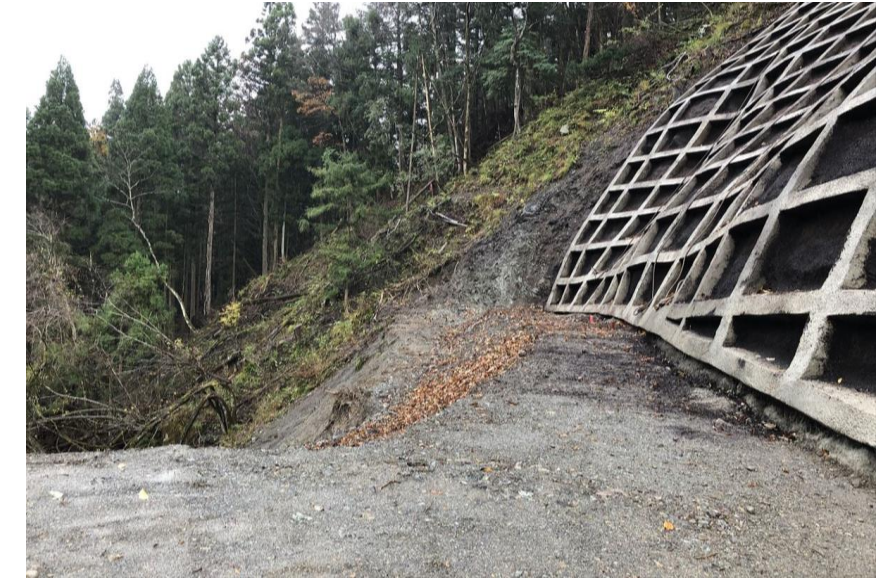
⑤ 下流工事用道路状況
