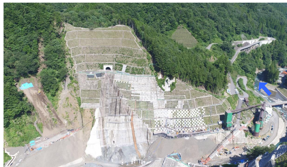
③ ダムサイト左岸状況(右岸上空より望む)
