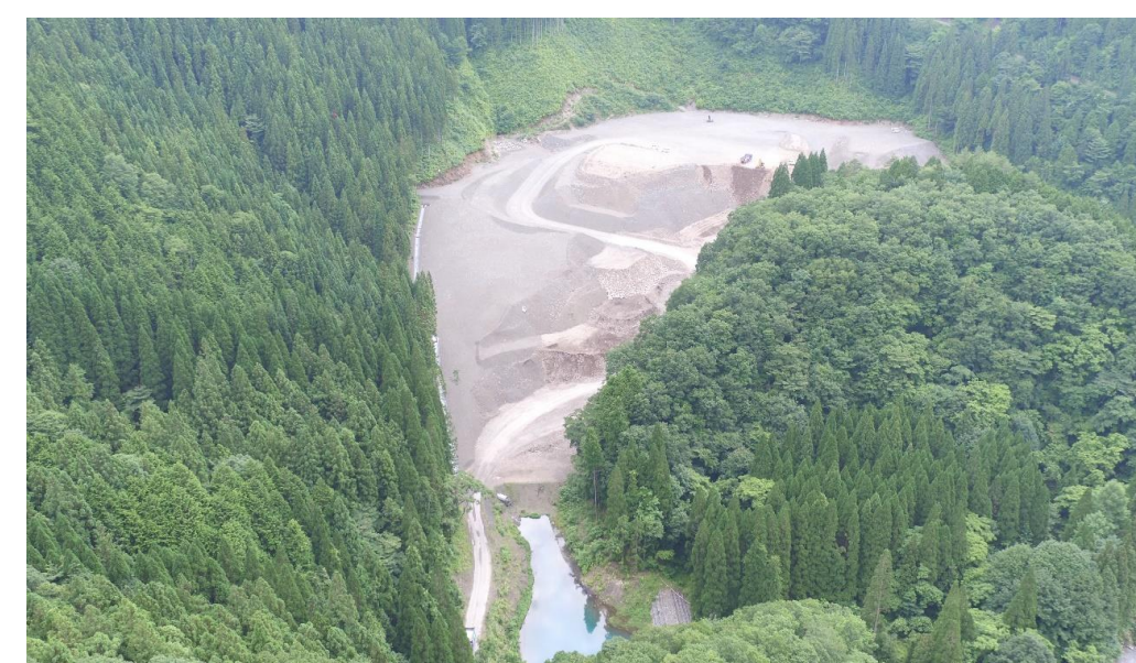
⑦ 残土処理場状況
