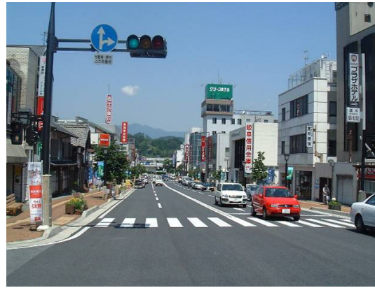
中津川市の市街地（電線類の地中化）
