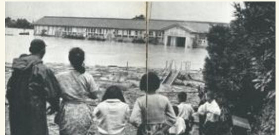
台風で浸水した小学校(養老町)
