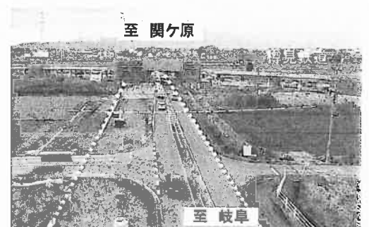
(主) 岐阜関ヶ原線 宗慶・温井Ⅱ期工区 工事状況
