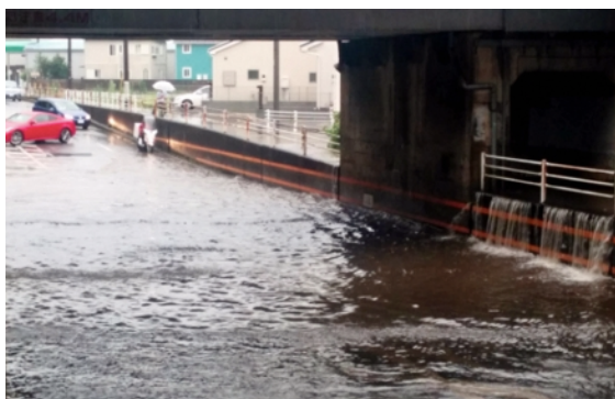
道路冠水被害
