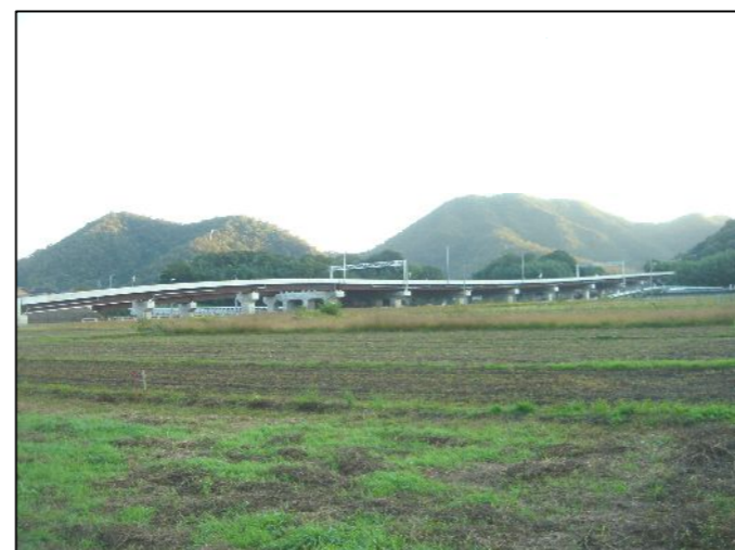
国道156号・岐阜東BP(岐阜市)
