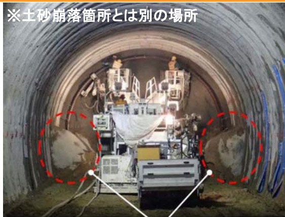
トンネル下部の地山の掘削前状況
