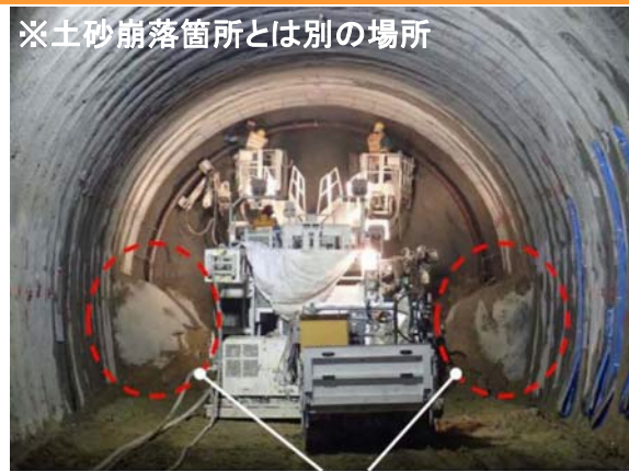
トンネル下部の地山の掘削前状況
