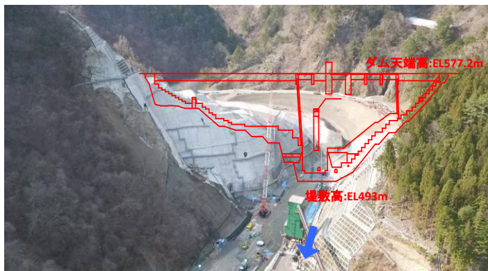
② ダムサイト状況(下流上空より望む)
