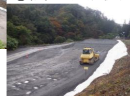
⑧ 仮置き造成状況
