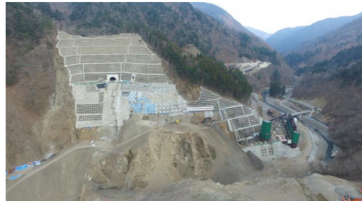
③ ダムサイト状況(右岸上空より望む)
