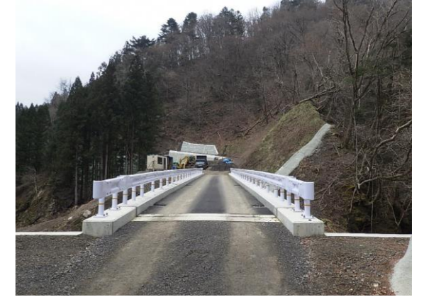
⑤ 下流工事用道路状況
