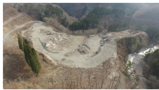
⑦ 原石山状況(上空より望む)
