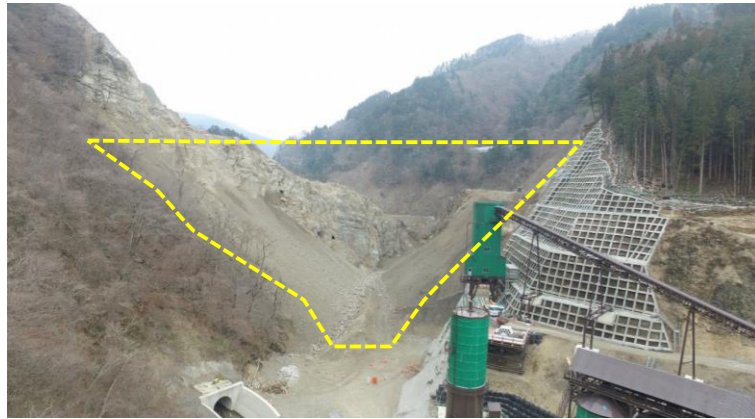
① ダムサイト状況(遠景:下流上空より望む)
