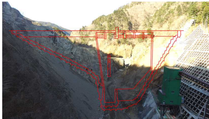
② ダムサイト状況(近景:下流より望む)
