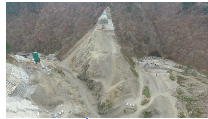
④ ダムサイト状況(左岸上空より望む)
