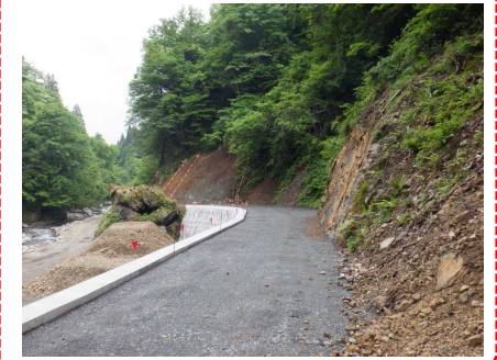
⑤ 下流工事用道路状況
