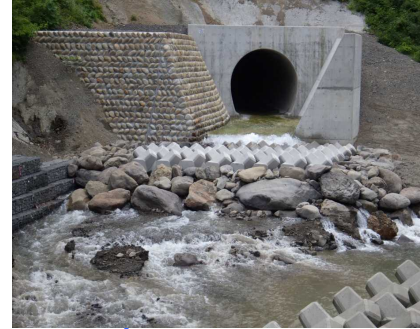
④ 仮排水トンネル吐口状況
