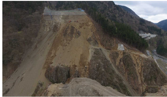
② ダムサイト状況(右岸上空より望む)
