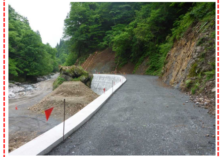
⑤ 下流工事用道路状況
