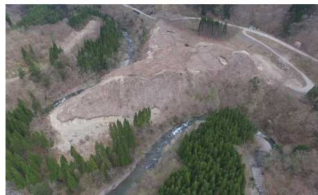
⑦ 原石山状況(上空より望む)
