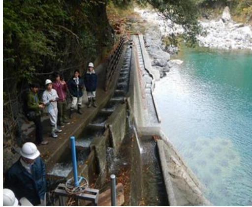
FWSによる魚道点検状況【根尾川（本巣市）】
