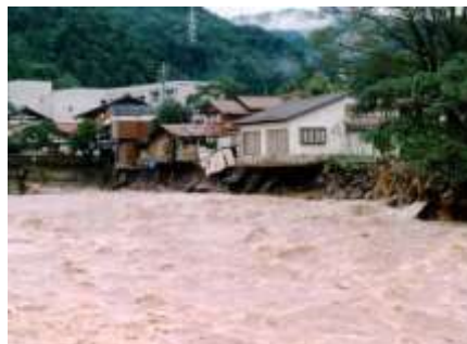
長良川 郡上市高鷲町地先（平成 11 年）
