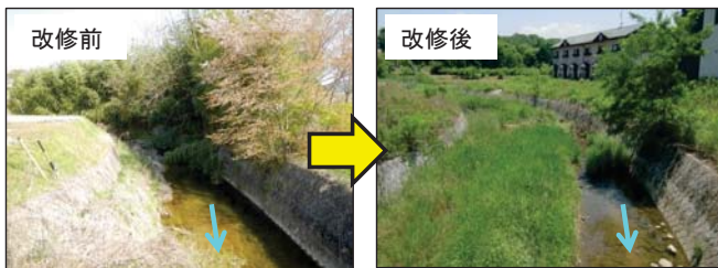
河川環境・護岸前面の植生回復状況 (1.8k付近)
