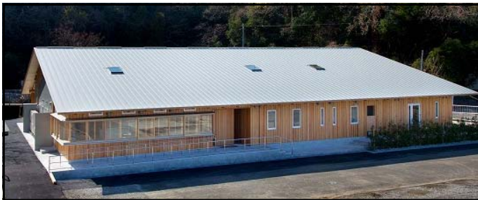
林業人材育成棟 外観
