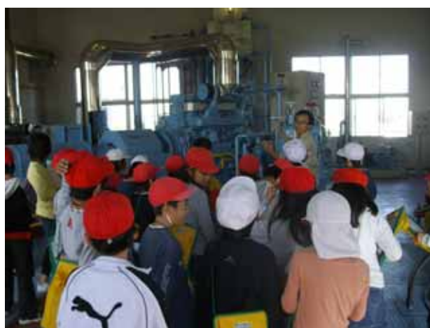
《境川排水機場の見学》 排水機場の効果について学びました。
