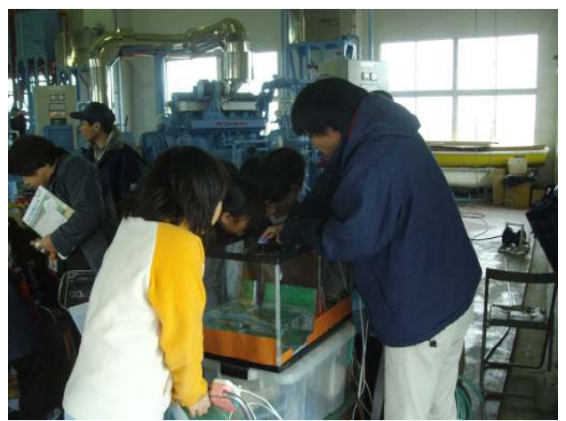
《境川排水機場の見学》 排水機場の効果について学びました。
