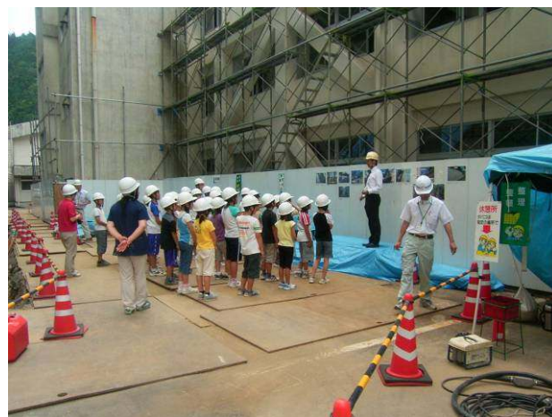
工事現場での説明の様子
