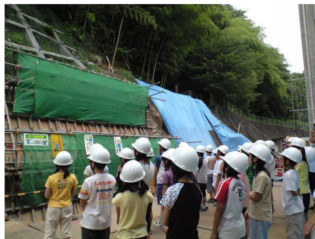
工事現場での見学の様子
