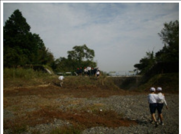
現地にて砂防堰堤の見学
