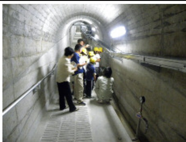
堤体内監査廊見学
