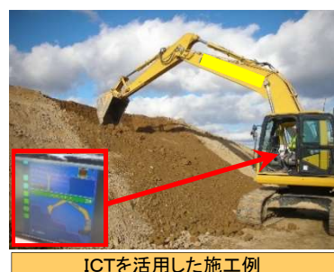
ICTを活用した施工例
