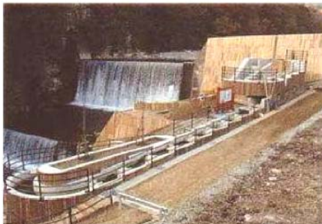
魚がのぼり易い川づくり推進モデル事業 （上坂本魚道、二連トラック式スパイラル魚道、 郡上市明宝）
