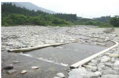
エコ・リバー実施箇所 (魚道の設置)
