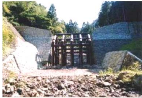
スリット式砂防堰堤
