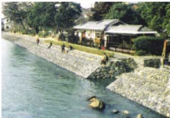
護岸が「地」に溶け込んだ事例
