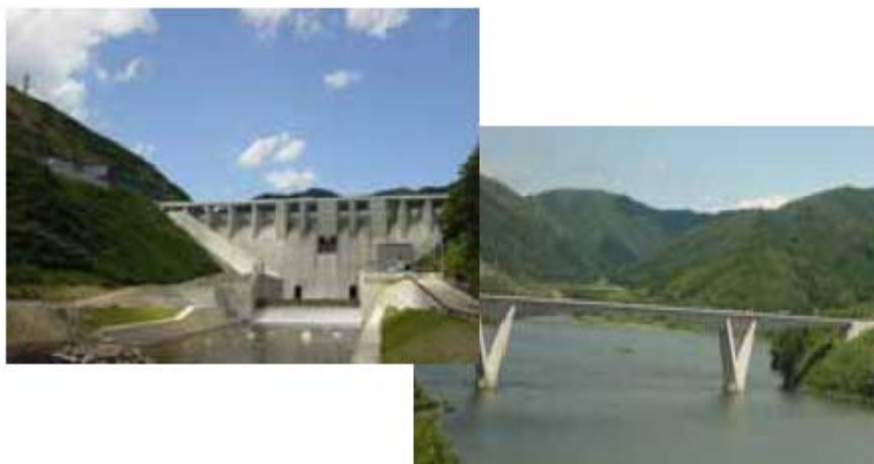
管理所や頂部構造を含むダム、周辺の道路、橋梁、トンネル等が総合的にデザインされている事例（苦田ダム） 3)
