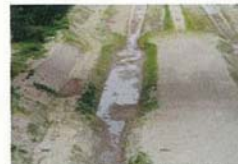
復元工法実施前の写真
