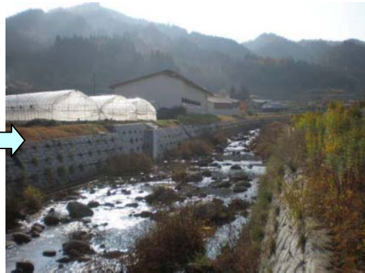
瓜巢川（高山市国府町金桶地内） H20.11 捨て石により、瀬と州が形成・維持され、多様な流れと植生が見られる。
