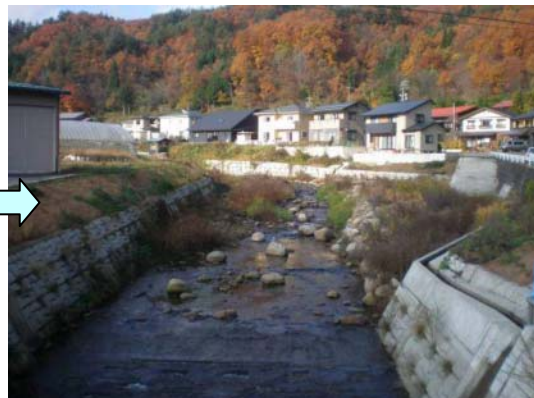
瓜巢川（高山市国府町金桶地内） H20.11 旧川の高水敷部分及び低水路の州に植生が見られる。
