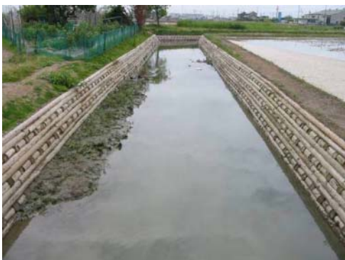
護岸前面の盛土
