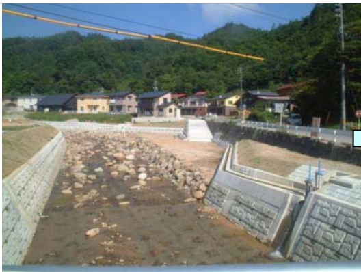
瓜巢川（高山市国府町金桶地内） 施工直後 旧川部分を石材により高水敷として処理し、余裕のある河川空間としている。
