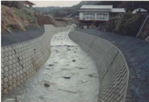
円光寺橋より60m程上流。護岸は植生できるように、空隙のある環境保全型ブロックを使用した。植物が繁茂するように配慮した。
