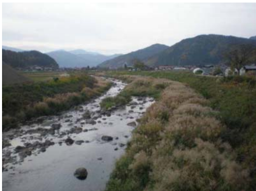
木工沈床部分に州が形成され、植生が回復している。
