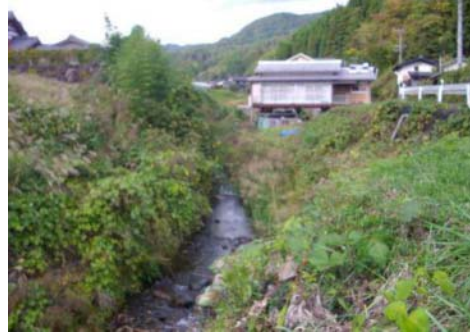
H20年10月29日撮影。円光寺橋より60m程上流。環境保全型ブロックにおいて植生が確認できる。河床に植生が確認できる。
