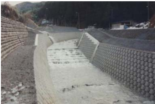
円光寺橋より160m程上流。川底に高低差（落差）がある箇所では、川幅全体にわたって、斜路工を設置した。また、合わせて柵田式魚道を設置した。
