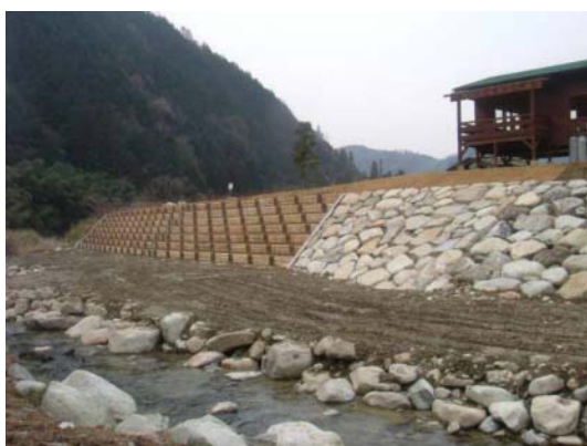
白川（白川町和泉地内） 施工直後
