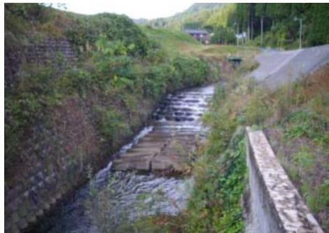
H20年10月29日撮影。円光寺橋より160m程上流。現在も魚道工が維持されている。
