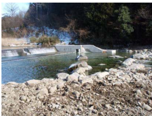
黒川（白川町三川地内） 施工直後
