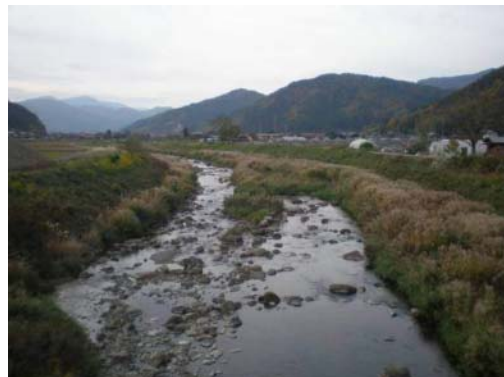
緩勾配の連結自然石覆土護岸に植生が回復し、周囲の景観と調和のとれた河川空間が保全されている。
