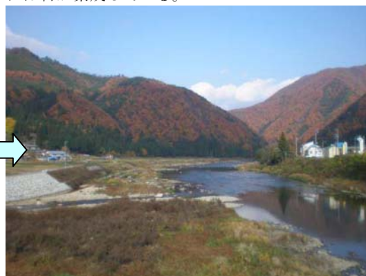
宮川（飛騨市古川町谷地内） H20.11 土羽法面に植生が繁茂し、背後地との連続性が保たれている。
