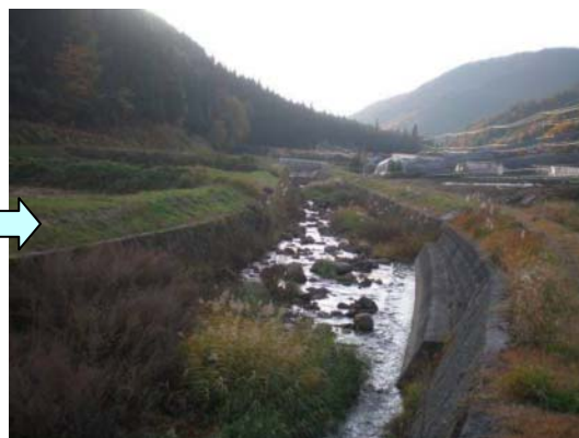
蔵柱川（高山市上宝町蔵柱地内） H20.11 捨石により瀬と州が形成され、変化のある河道空間 が形成されている。
