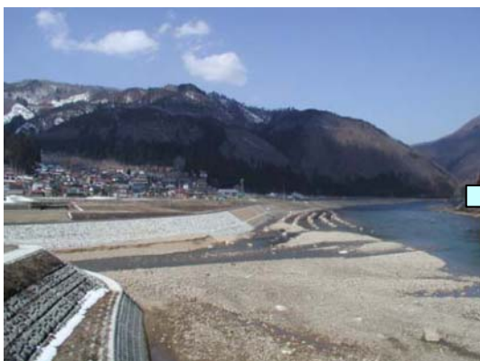
宮川（飛騨市古川町谷地内） 施工直後 土羽護岸と寄石により、植生に配慮している。
