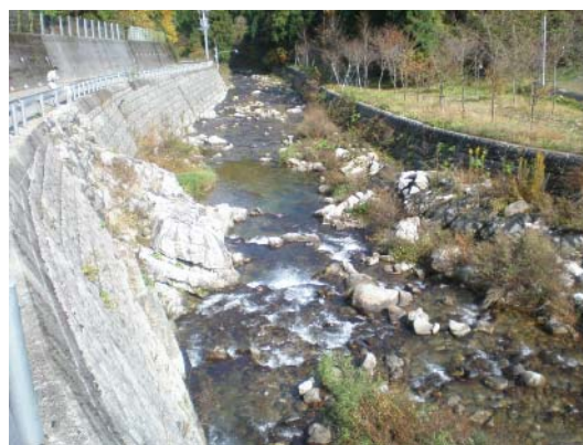
稲越川（飛騨市河合町大谷地内） 現地発生材の活用 護岸の洗掘傾向にある箇所に、現地発生石材を用いた袋詰玉石工を施工し、コンクリートを使用しない現地発生の根固工とした。
