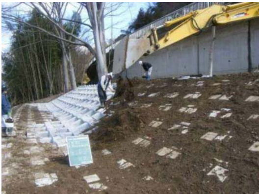
H20.3 施工状況(表土覆土)
