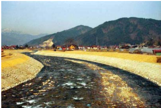
木枠付の根固めブロックを使用し、中に川の石を投入して、魚類や水生昆虫の棲家になるように配慮した。
