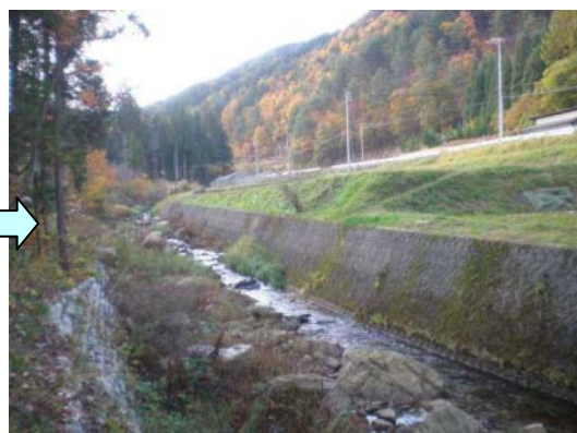
蔵柱川（高山市上宝町蔵柱地内） H20.11 ポーラス間知ブロックによりコンクリート面のか なりの部分が苔により覆われている。
