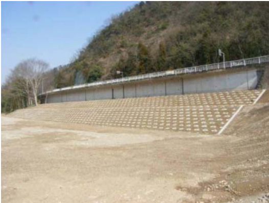
H20.3 完成状況(表土覆土)
