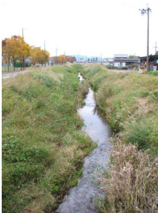
写真-2.5.2 良好な区間を見つけることは難しいことではない (石田川でのケーススタディでは、改修区間の上流部の姿をお手本とした)
