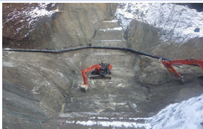
MGバックホウ施工状況
