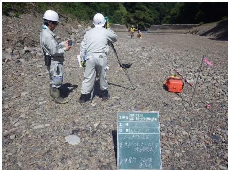
TS出来形測定実施状況
