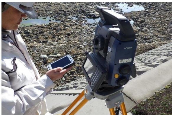
TSによる測量(出来形測量)
