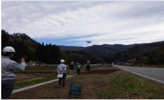
UAVによる写真測量(起工測量)
