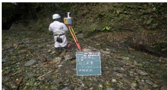
レーザーสキャナによる測量(出来形測量)
