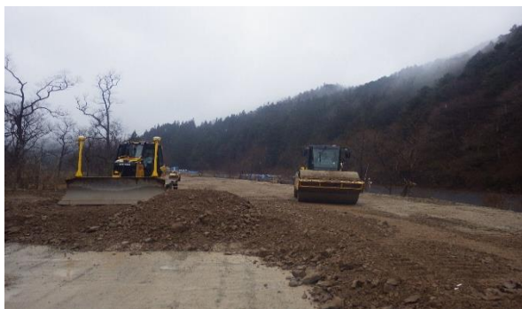
MCブルドーザー施工状況
