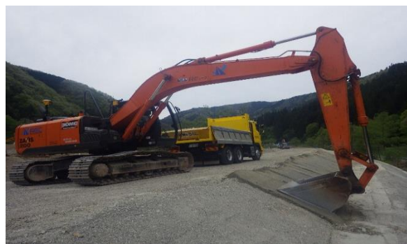
MCバックホウ（法面整形）施工状況
