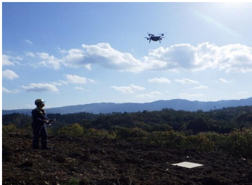
UAVによる写真測量(起工測量)
