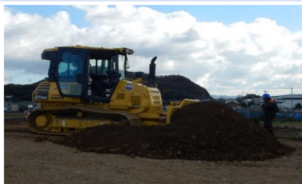
MCブルドーザー施工状況
