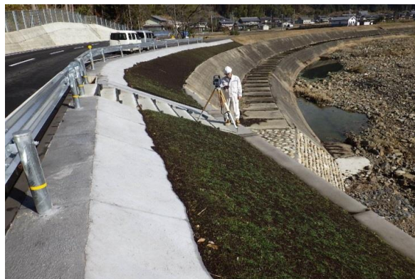
TSによる測量(出来形測量)
