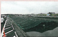
アユふ化水路全景 (紫外線防止ネットを水路上に張った状況)
