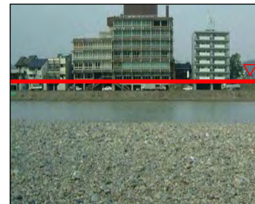
痕跡水位（長良橋右岸上流）
