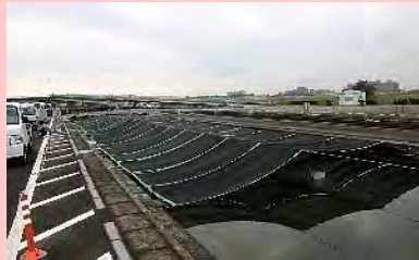
アユふ化水路全景 (紫外線防止ネットを水路上に張った状況)
