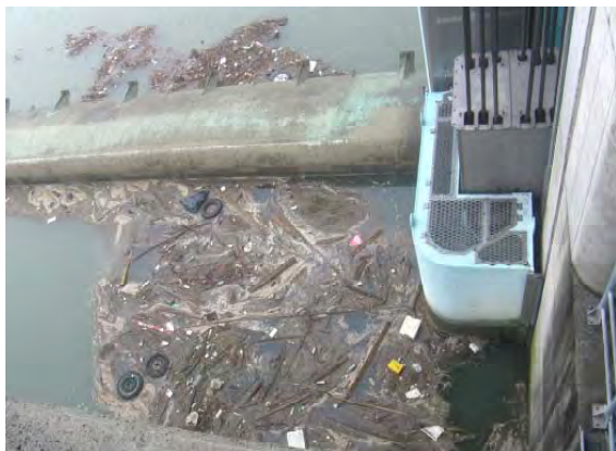
(堰上流部に滞留した流木・塵芥)
