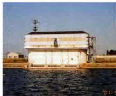
長良導水取水口(平成10年4月取水開始)
