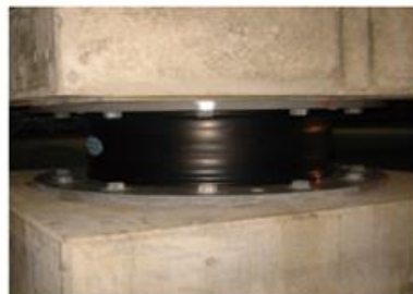
免震装置 (鉛プラグ挿入型積層ゴムアイソレータ)
