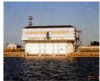
長良導水取水口（平成10年4月取水開始）
