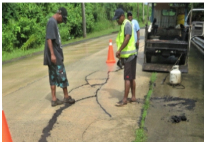
道路の補修と点検
