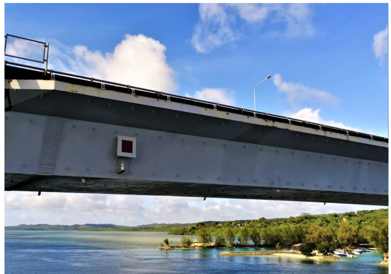
橋の側面 点検
