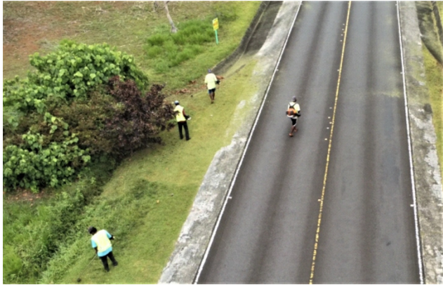
道路周辺の草刈り 整備作業
