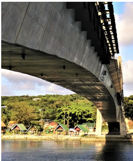
橋の裏側 点検
