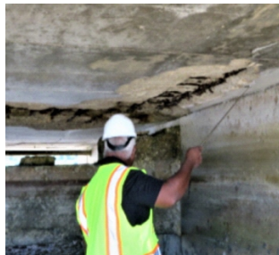
コンクリートを叩いて点検
