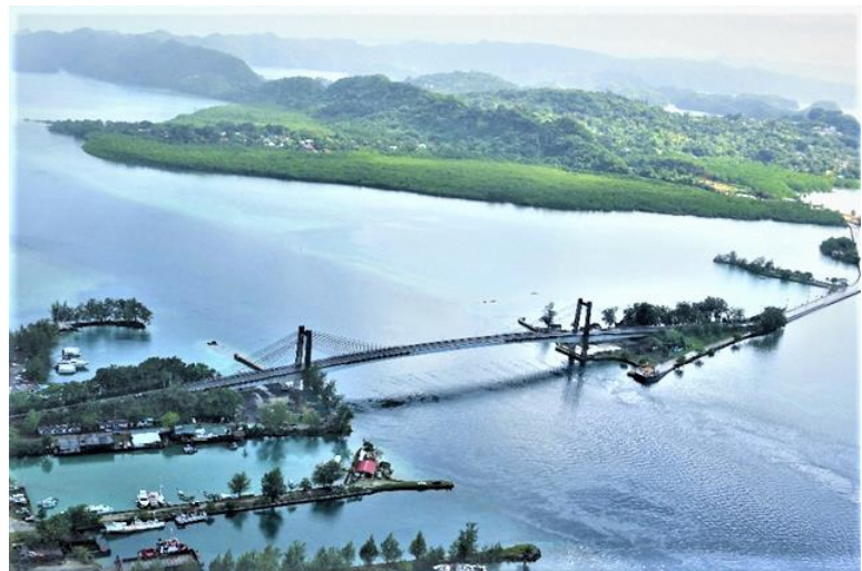
日本パラオ友好橋（新 KB ブリッジ）
