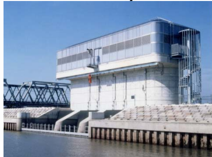
長良導水取水口 (平成10年4月取水開始)
