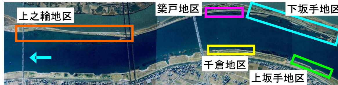
ヨシ原再生事業実施前(平成10年9月撮影)
