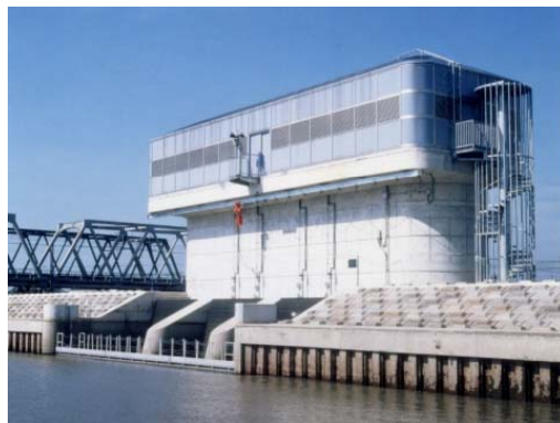
長良導水取水口 (平成10年4月取水開始)
