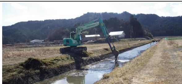
河川内の藻およびゴミの撤去の状況(管瀬川 揖斐川町)
