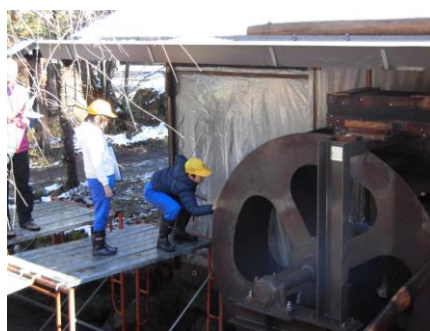
発電施設を利用した環境保全学習
