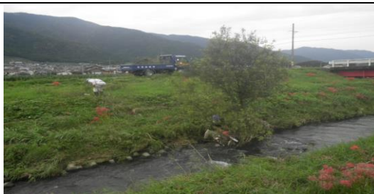
樹木伐採の状況(杭瀬川 池田町)
