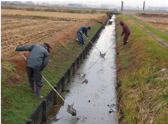
水路での駆除作業状況 (輪之内町)
