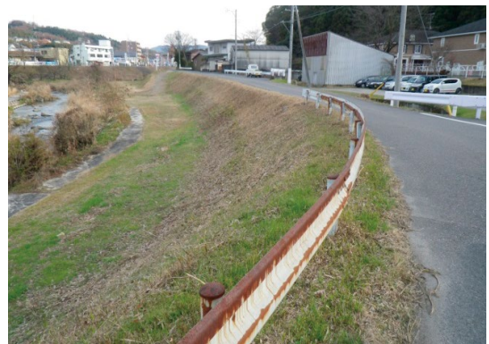
笠原川(多治見市平和町~京町)施工後
