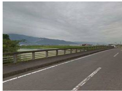
調査地点: 石亀橋
