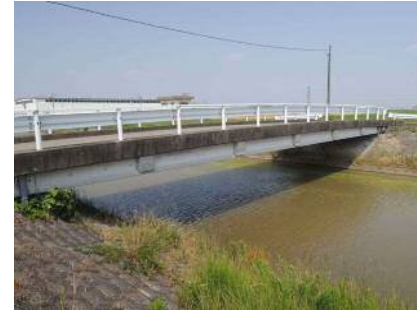
調査地点1: 上一色橋付近
