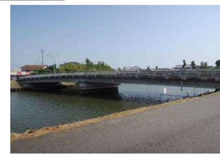
調査地点c: 築留橋
