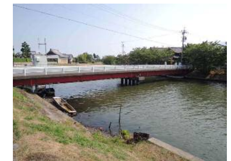
調査地点9: 辛亥橋
