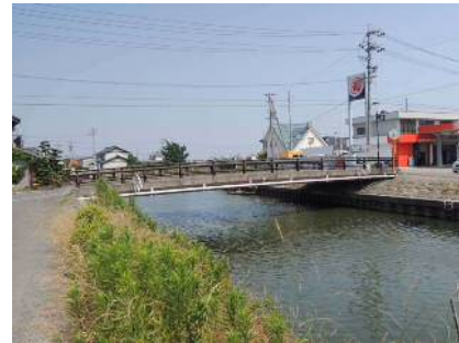
調査地点6: 大江橋付近
