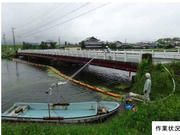
写真 2.5 高圧水放水による攪拌作業状況 (8月18日 万寿橋)
