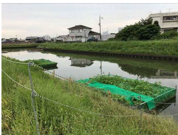
写真 2.15 空芯菜を用いた水質浄化対策の実施状況 (H29. 6~H29. 11)
