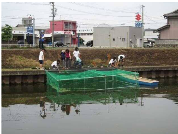
写真 2.14 空芯菜を用いた水質浄化対策の実施 (H29. 6~H29. 11)
