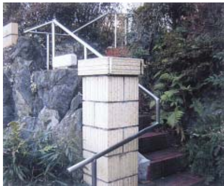
屋外階段（アプローチ）
