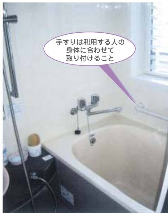
手すりの設置
