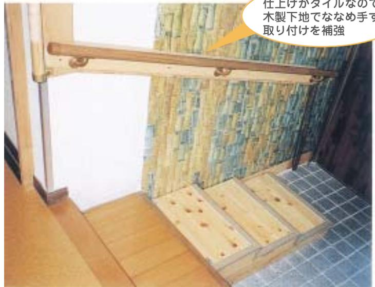
仕上げがタイルなので、木製下地でななめ手すり取り付けを補強
