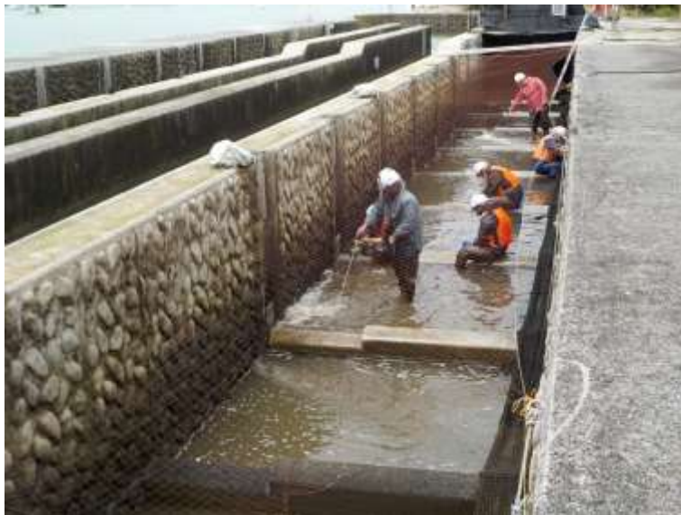
呼び水式魚道清掃（H30.4.18）
