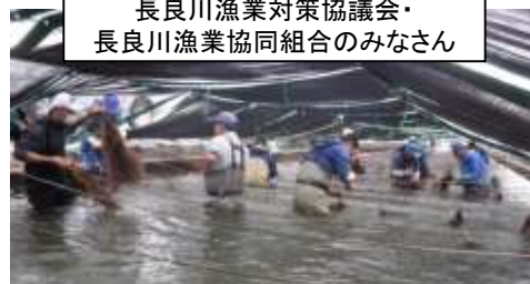
シュロの装着作業（水路に設置した横断ロープに装着）
