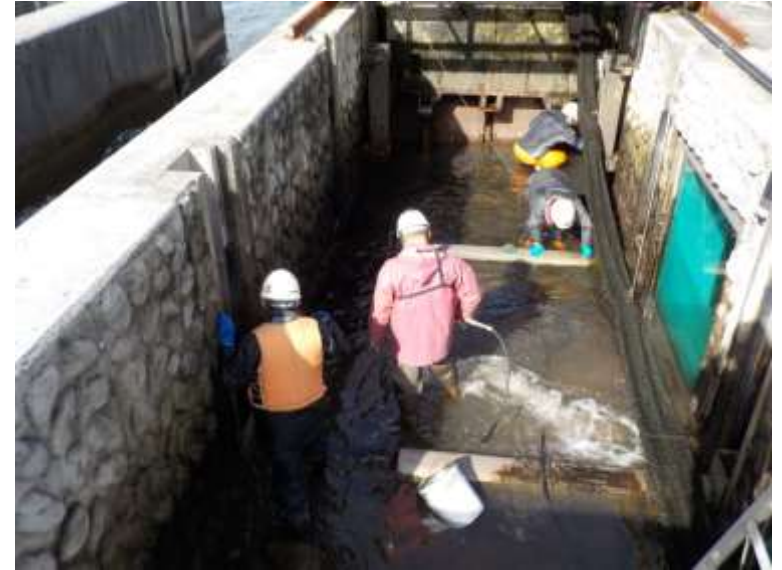
呼び水式魚道清掃（H30.1.19）
