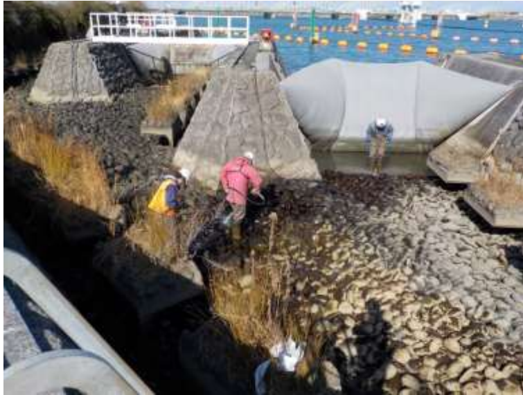
右岸せせらぎ魚道清掃状況（H30.1.19）
