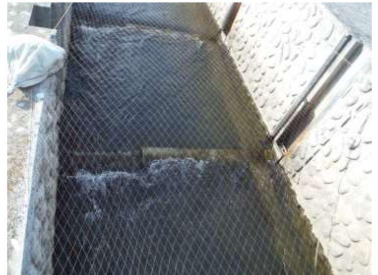
呼び水式魚道への防鳥ネット設置
