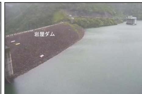
洪水貯留開始前の貯水池の状況 (7月4日9時頃)
